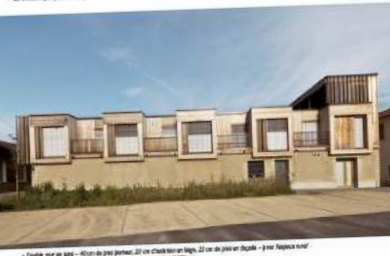
À l'été 2014, le projet maison L'arbre-Alcôve a été conçu pour être à l'origine de parois perspirantes.
